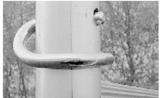
Заключващ механизъм на рамите
